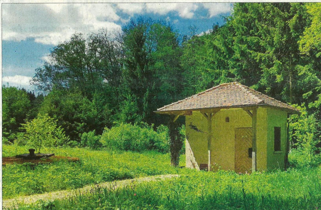
Die Wasserpumpstation im Schaichtal: Ein Fragment der Geschichte unserer Wasserversorgung.
